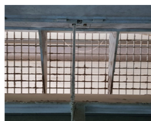
[그림 14] 배플 입기구에 설치된 방조망
